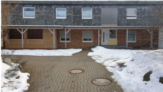
Foto 1 Bestandswohnhaus (Blick vom ‚Heideweg‘, von Westen) - nur der rechte (südwestliche) Teil liegt im Plangebiet
